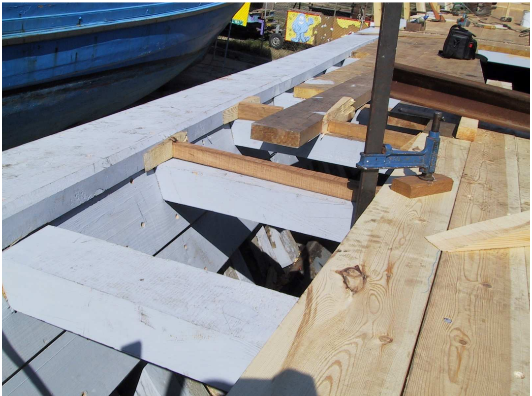
Els nous baus i part de la coberta
