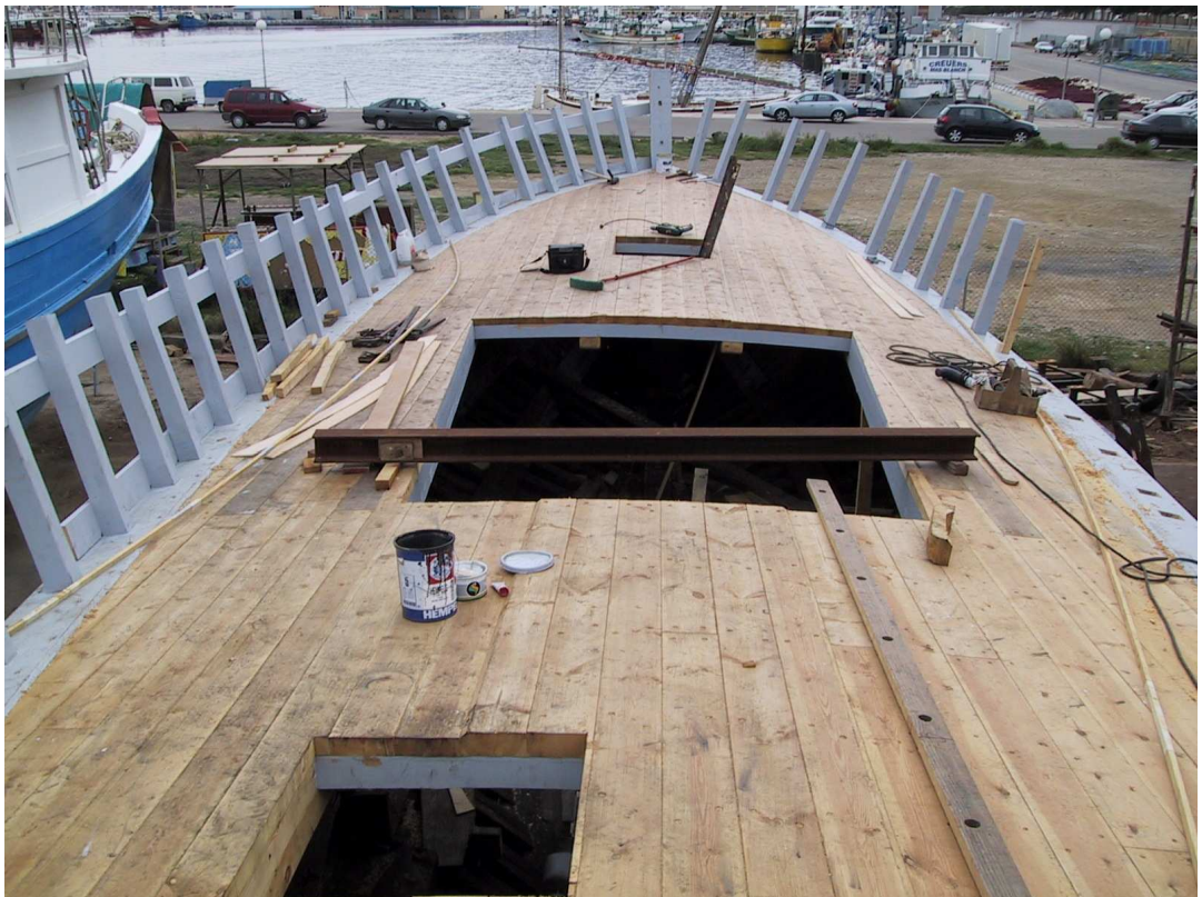
La nova coberta i les obertures pel balou i tambutxos
