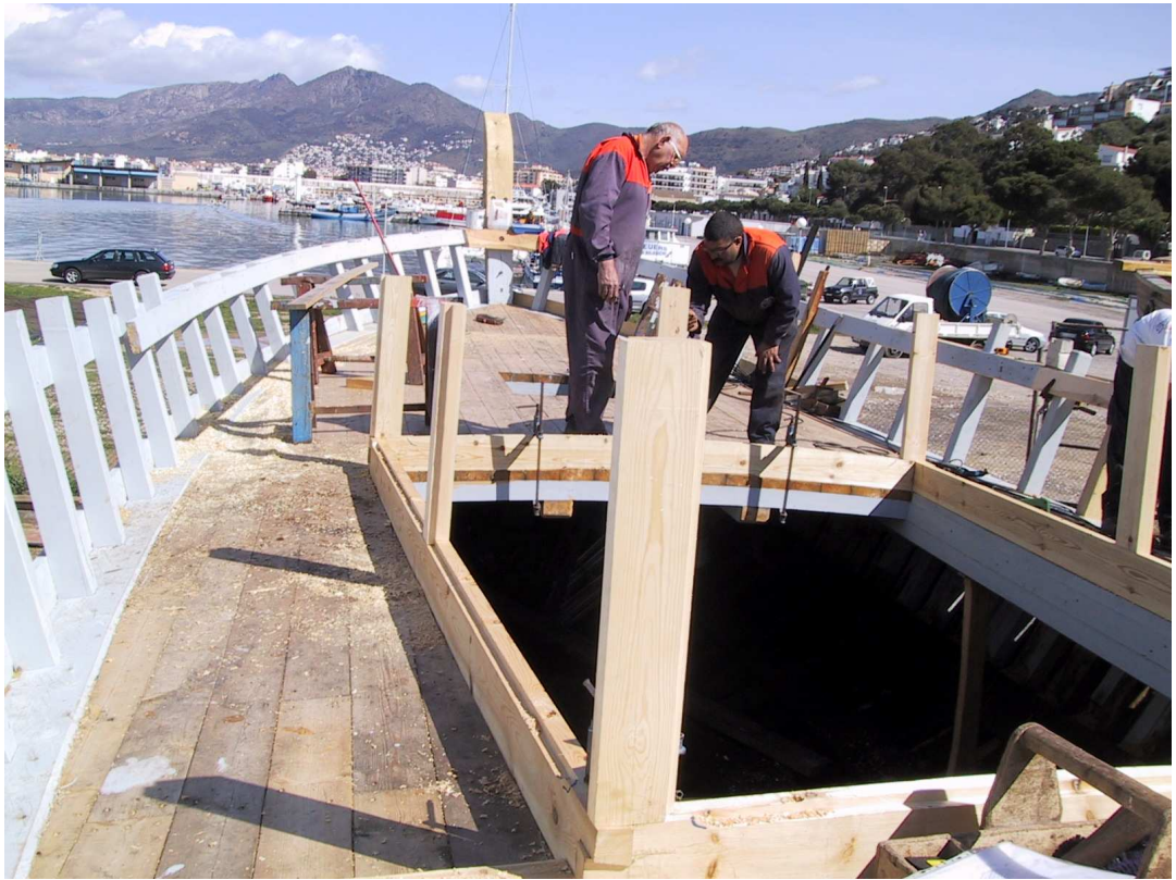
Construcció del balou
